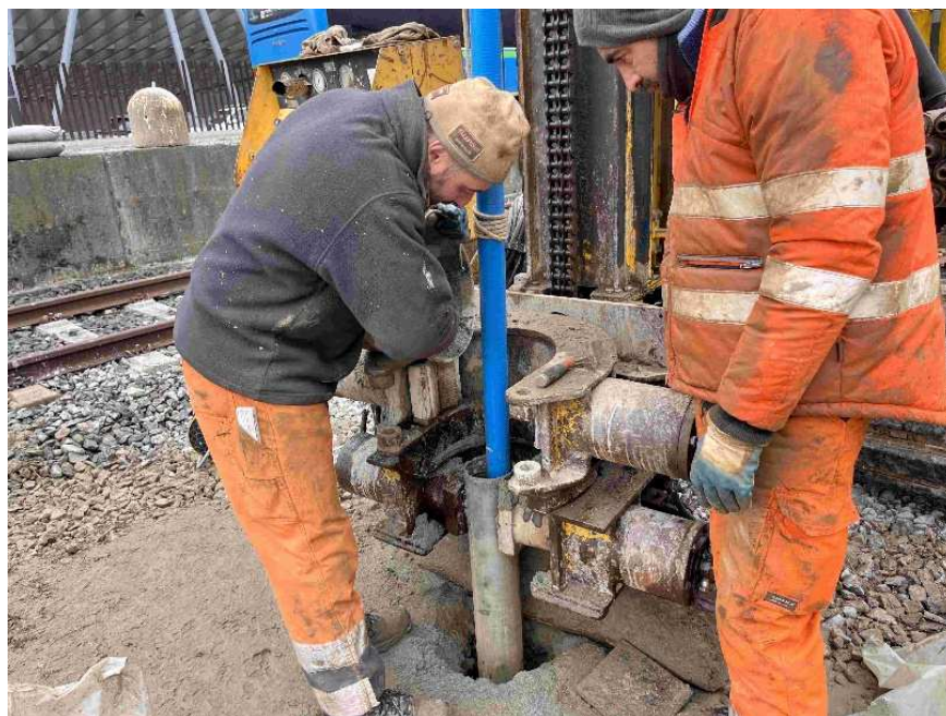
Figura 11 – Installazione tubo piezometrico in pvc diametro 2”.
