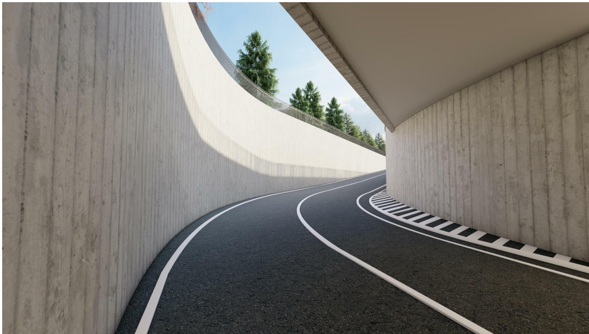
Imbocco lato via Zeuner
