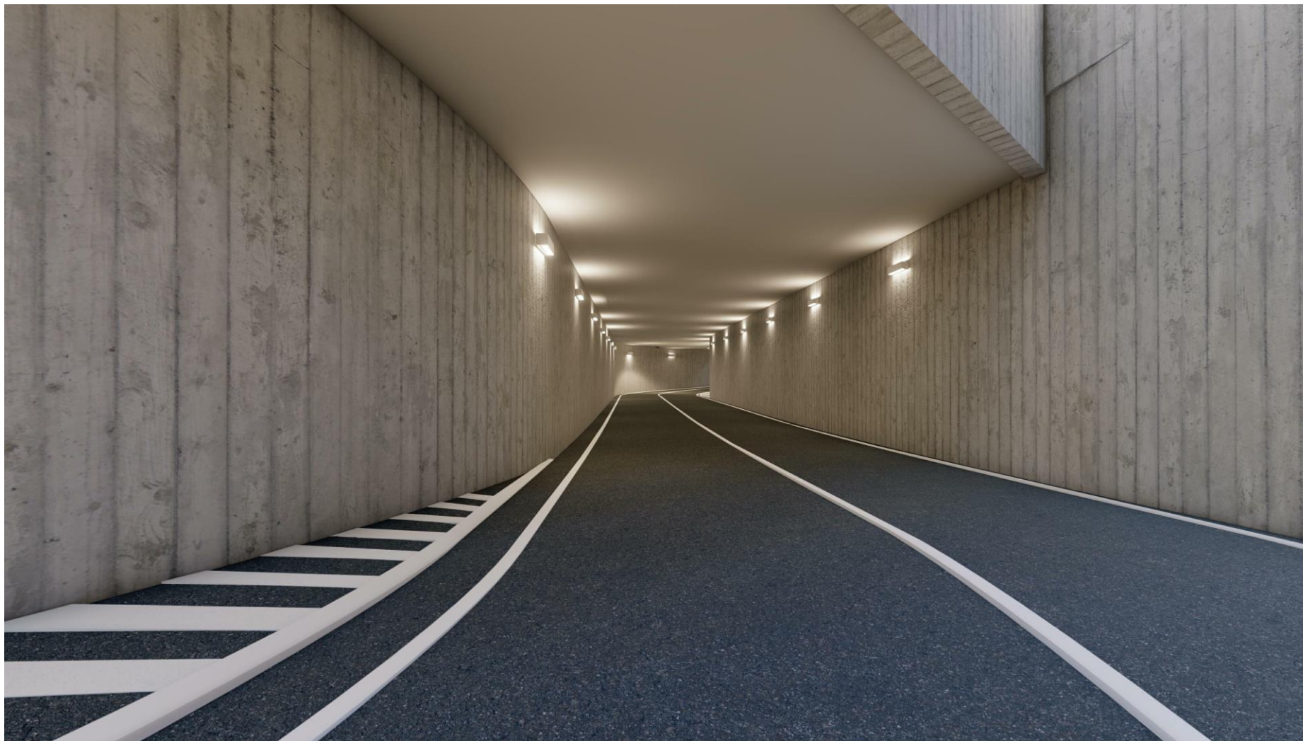
Imbocco lato via Sanzio
