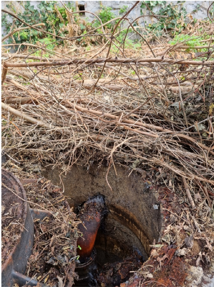
Cameretta e tubazione presente su scarpata ferroviaria
