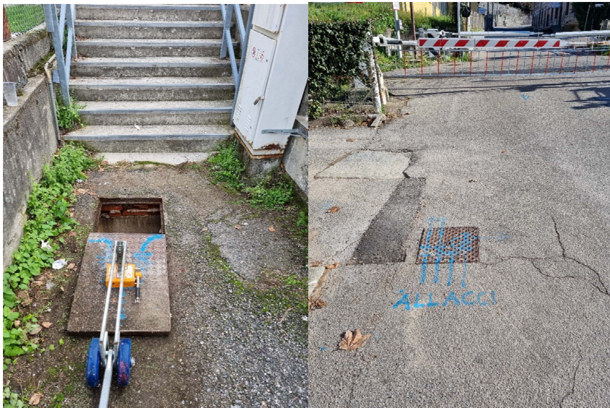
Pozzetto stacchi utenze passerella pedonale e pozzetto attraversamento Via VI Novembre
