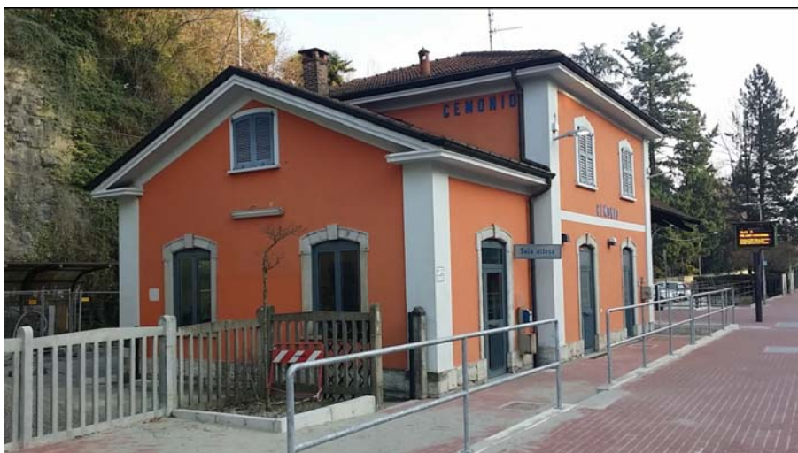
Figura 9.3: Foto successiva ai lavori di innalzamento del primo marciapiede con risoluzione dislivello
