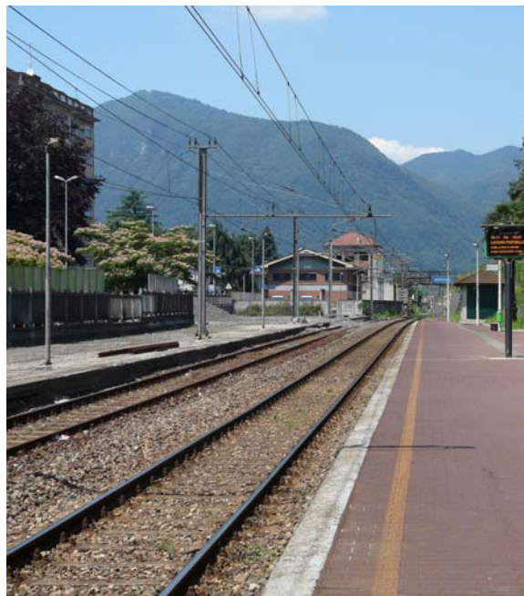
Figura 9.2: Foto precedente i lavori di innalzamento del primo marciapiede
