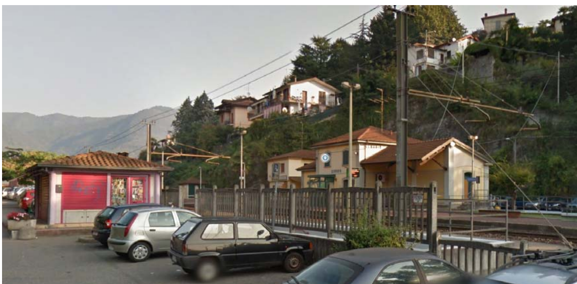
Figura 9.5: Vista dell'accesso al sottopasso dal lato ovest
