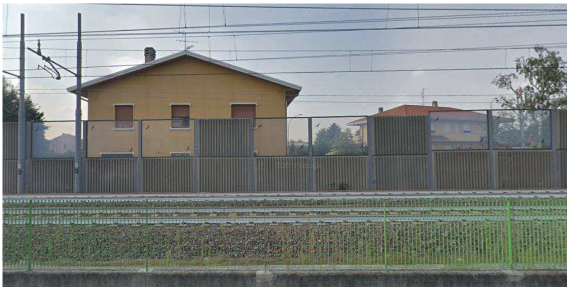
Figura 6.4: Vista tipologia di barriera su tratta FERROVIENORD
