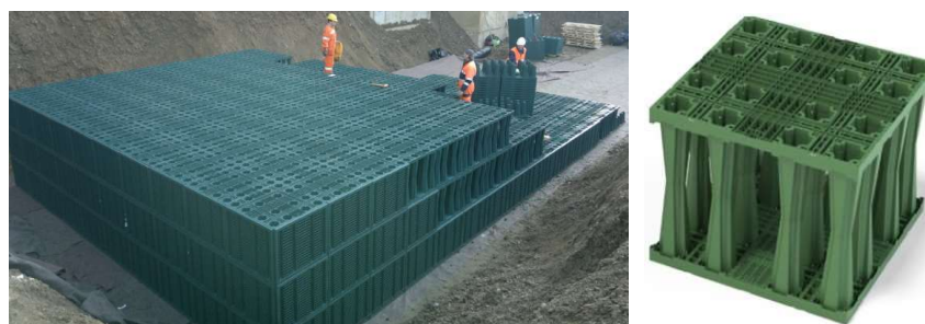
Trincea drenanti con moduli disperdenti in polietilene del tipo carrabile
